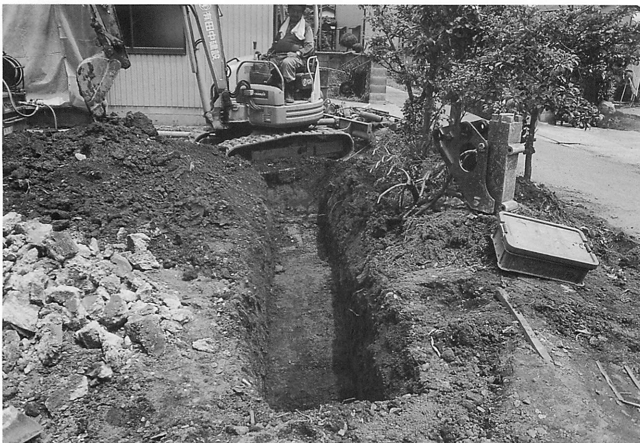
第41次調査 調査状況
