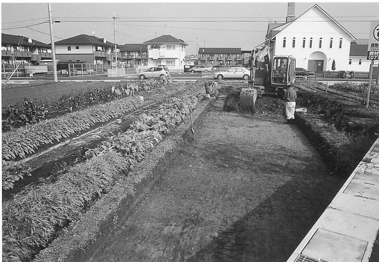
第36次調査 調査地全景
