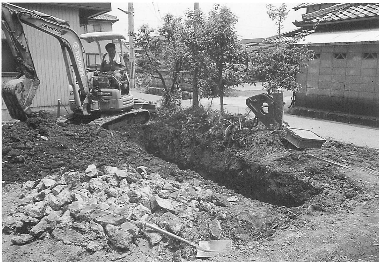
第41次調査 調査状況
